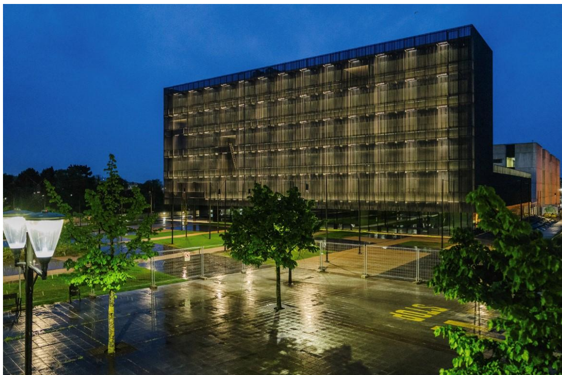
Edificio de la Comisaria de la Policía Local de Gijón
